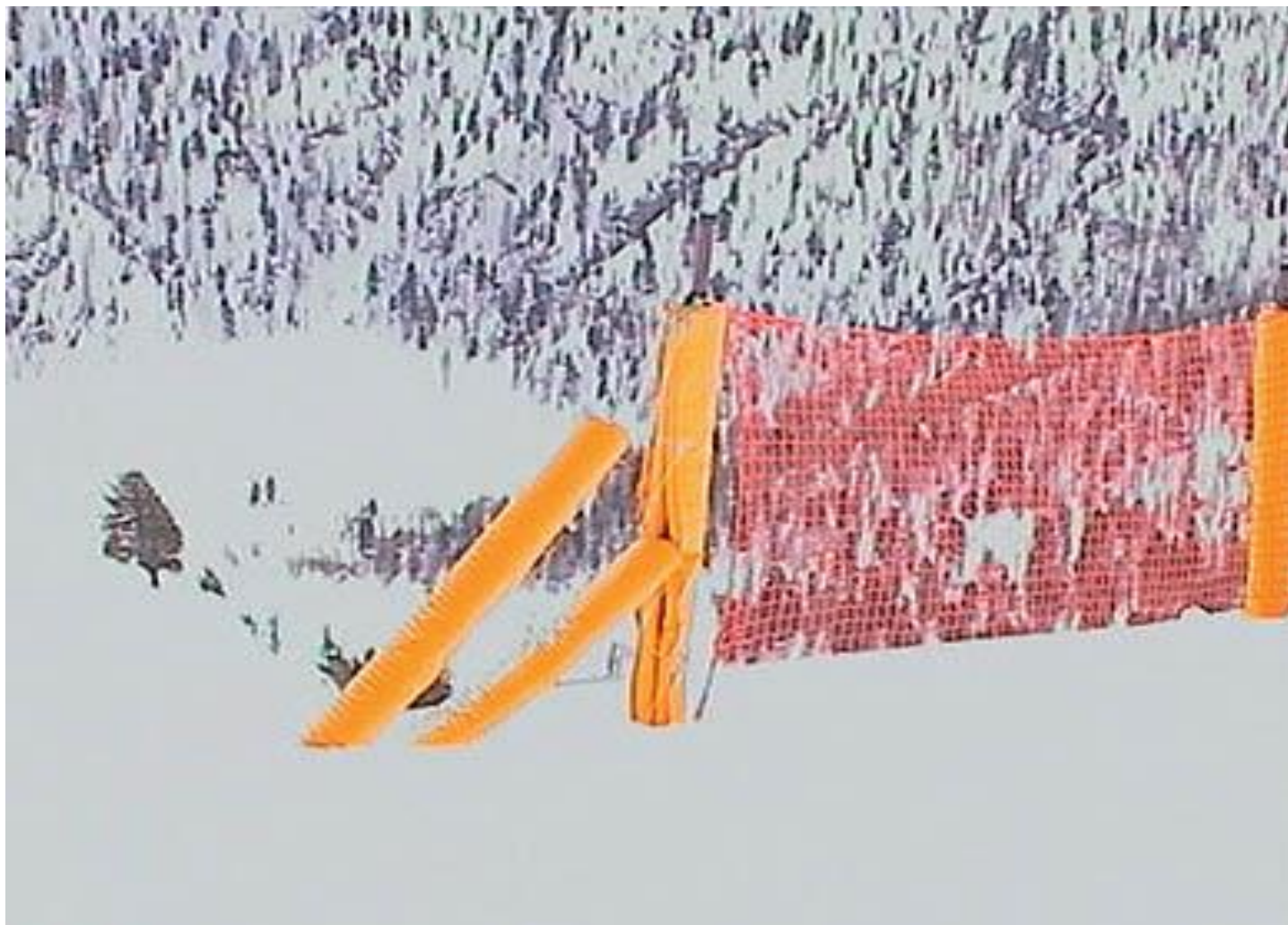
Posebne blazine za zaščito količkov in napenjalnih vrvi mrež
